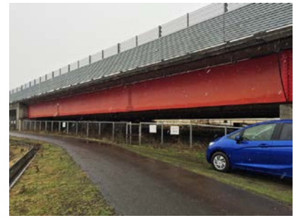
写真-1 対象橋梁
