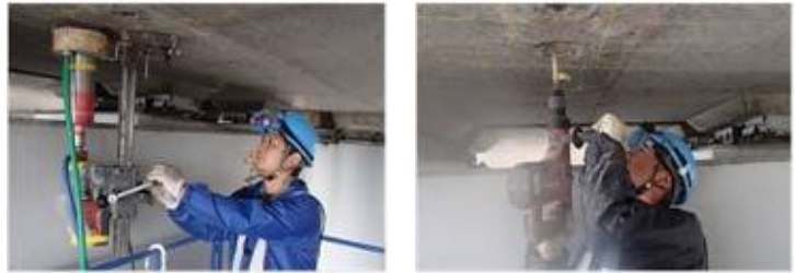
写真-2 削孔およびはつり作業状況
