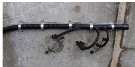
写真-3 センサ設置状況 (海側)
