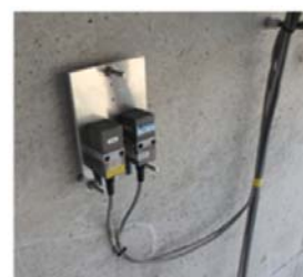
図-3 センサ設置状況 3)
