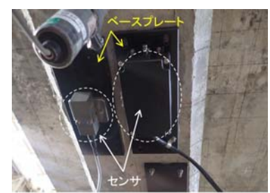
図-3 センサ設置状況
