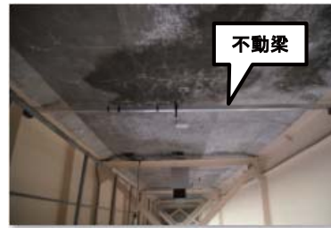
不動梁設置写真
