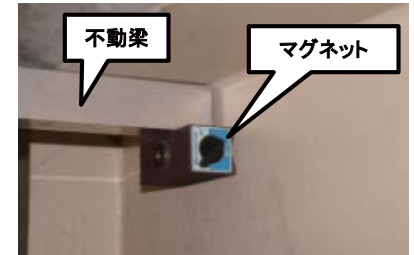
不動梁端部写真
