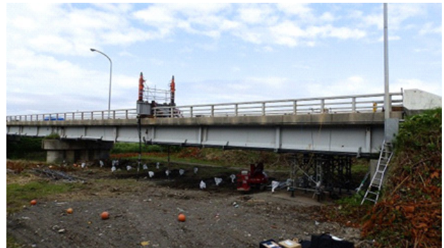
写真-1 対象橋梁と載荷状況
