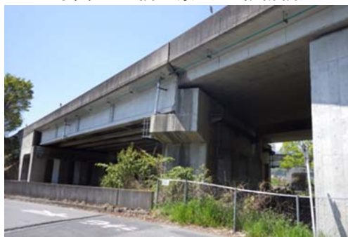
写真-2 M橋全景(PCI桁橋)
