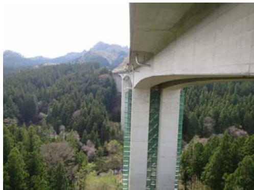
写真-1 U橋全景(PC箱桁橋)
