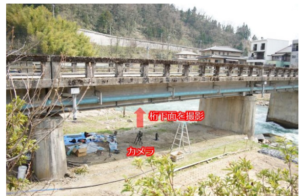
図3 計測対象橋梁とカメラの配置
