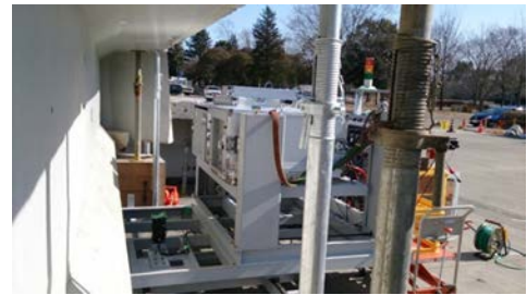
図-4 撤去桁の撮影状況
