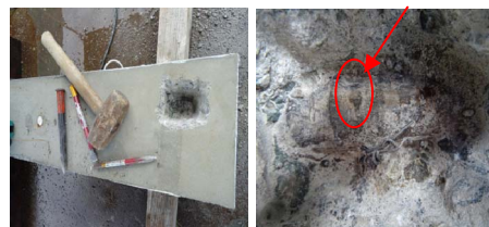
写真-2 はつりによる鉄筋腐食確認
