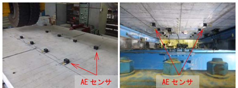
(1) 床版上面 (2) 床版下面
