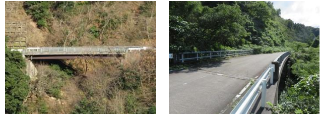
写真-1 対象橋梁
